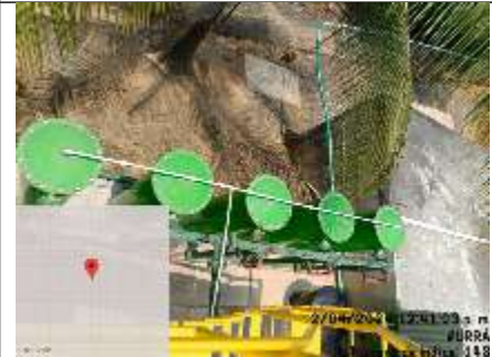
Fotografía A10 Filtros sistema de tratamiento aguas para consumo doméstico
