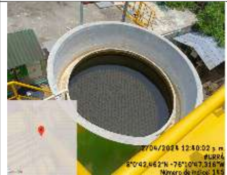
Fotografía A12 área sedimentación sistema tratamiento
