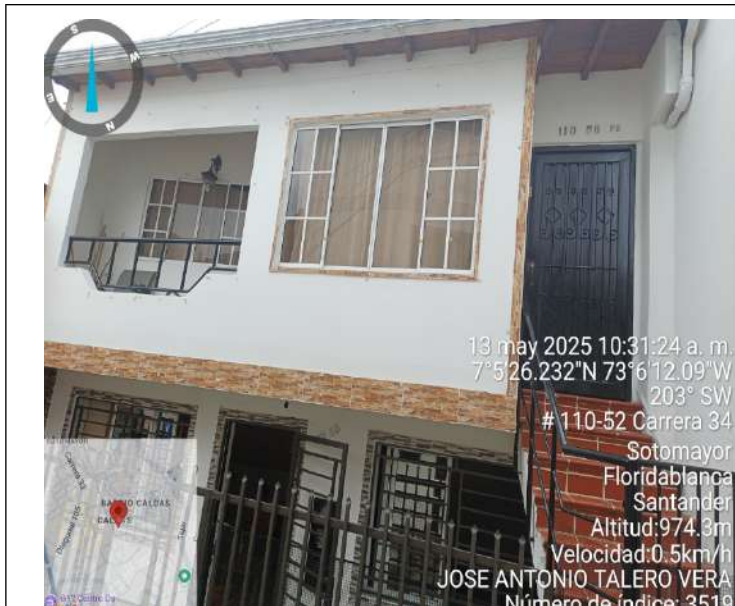
Fachada de la casa con nomenclatura Peatonal 34 Nos. 110 – 58 para los dos (2) pisos del Barrio Caldas, colindante mediante muros medianeros con unidades residenciales anexas
