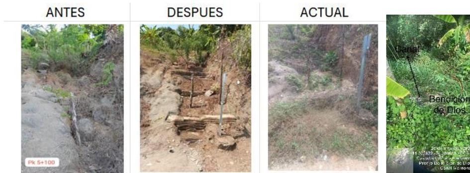
Imagen 4. Disipadores de energía instalados.
