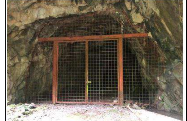
Foto 3.13 Ventana 1 de ingreso a la conducción
