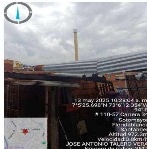
Vista al interior de la casa el Punto de descarga en tubo PVC de la chimenea artesanal del horno, sin las más mínimas normas de control del manejo de los gases y vapores generados durante el proceso de fundición, para que con buenas prácticas de ingeniería contrarrestar las presuntas emisiones fugitivas del material
