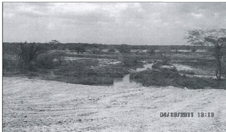
Ilustración 2. Vista panorámica desde la parte superior del botadero de estéril hacia la zona inundada por las aguas desviadas del caño Caimancito como consecuencia de la falla del botadero. Fuente: Concepto Técnico 935 del 22 de junio de 2011.
