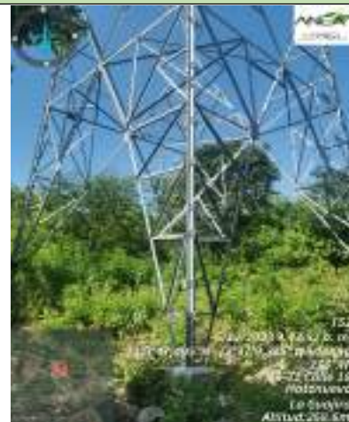
Fotografía 6 Sitio de Torre 52
