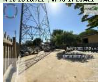
Fotografía 22 Invasión por infraestructura socioeconómica de la T232. Coordenadas Geográficas: N 10°28'28.722"; W 73°17'26.421"
