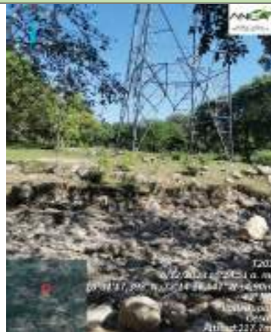
Fotografía 4 Sitio de Torre 203
