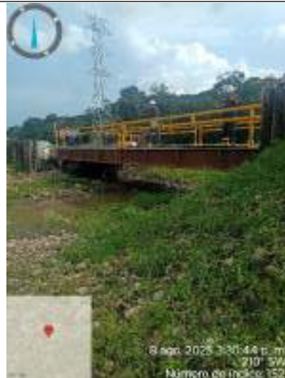
Fotografía 9. Pontones ubicados vía de acceso Coordenadas: OUN E: 5030568,51 N: 2035915,34
