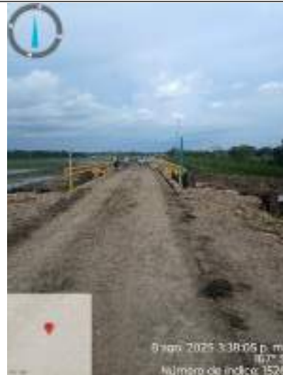
Fotografía 10. Pontones ubicados vía de acceso Coordenadas: OUN E: 5030668,42 N: 2035694.38
