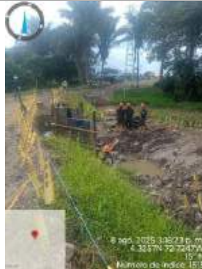
Fotografía 8. Construcción obras de drenaje Coordenadas: OUN E:5030535.21 N:2035992.67
