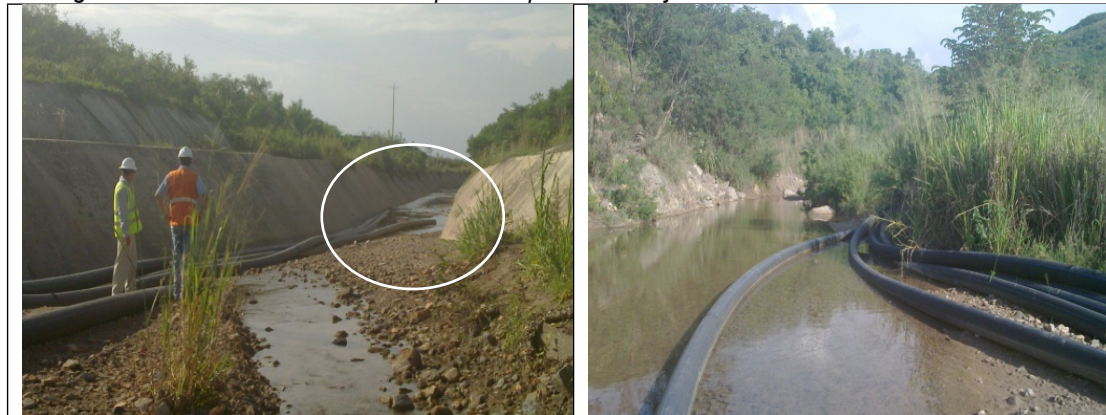
Figura 2. Vertimiento no autorizado para la operación conjunta realizado sobre el caño Canime
