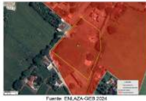
Patio de almacenamiento de Andalucía:
