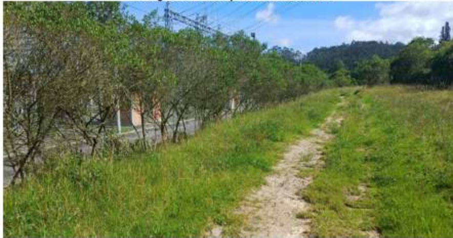
Fotografía 5 6Área plaza de tendido 14
