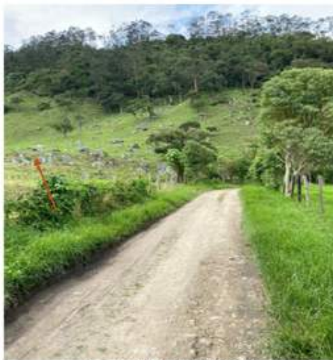
Fotografía 7 Área acceso Acc-PT2
