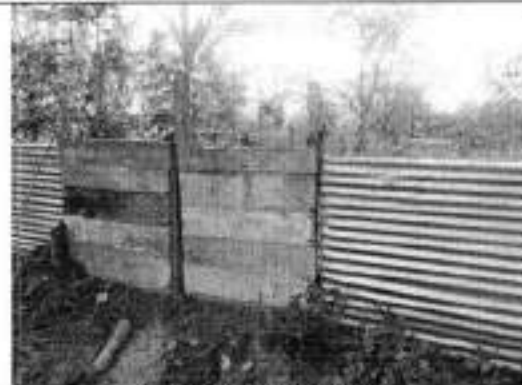
Acceso a las estructuras
