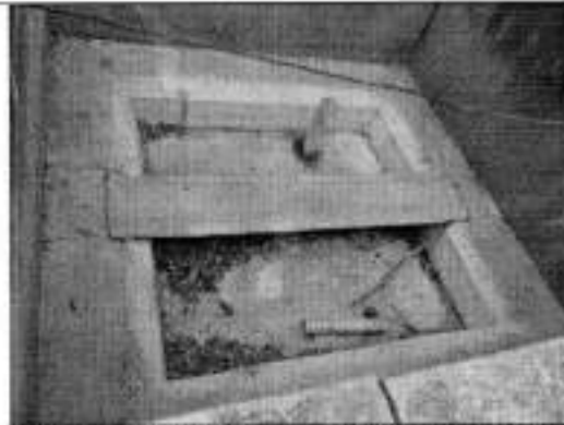
Pileta sin animales dentro del módulo donde se aprecia las características de construcción
