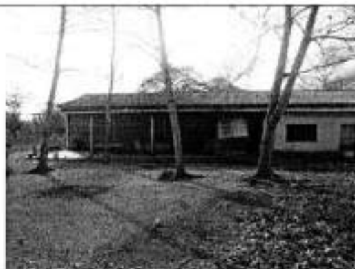
Zona de preparación de alimentos
