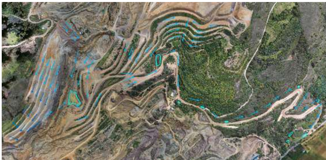
Figura 6. Sistema de drenaje mina Suescún
