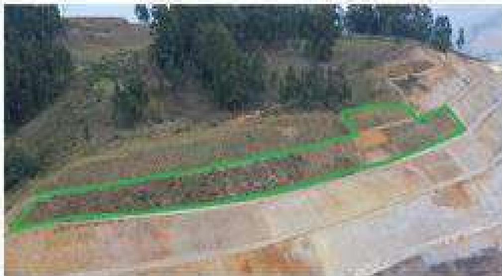
Zona 1 TALUD FINAL ZONA DE EXPLOTACIÓN
