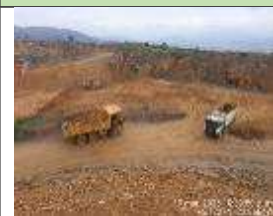
Fotografía 5. Área de retrolenado
