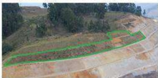
Zona 1 TALUD FINAL ZONA DE EXPLOTACIÓN
