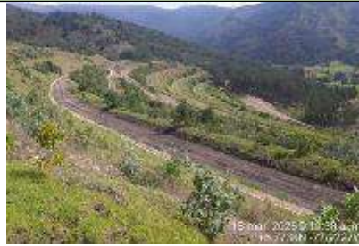
Fotografía 12. Cunetas pie de talud – Zodme Nobsa
