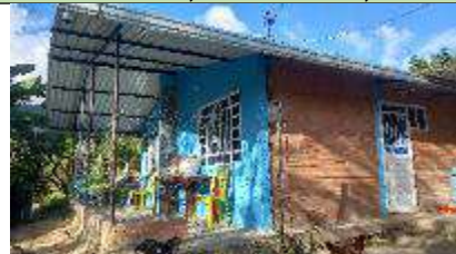
Fotografía 47. Vivienda receptora Misael y María Espinosa – Vereda Guina (Machetá) Coordenadas Origen Nacional E 4936191,28 – N 2119504,82
