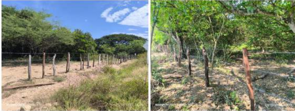
Figura 1. Captura de pantalla – Cerca perimetral instalado año 2024.
